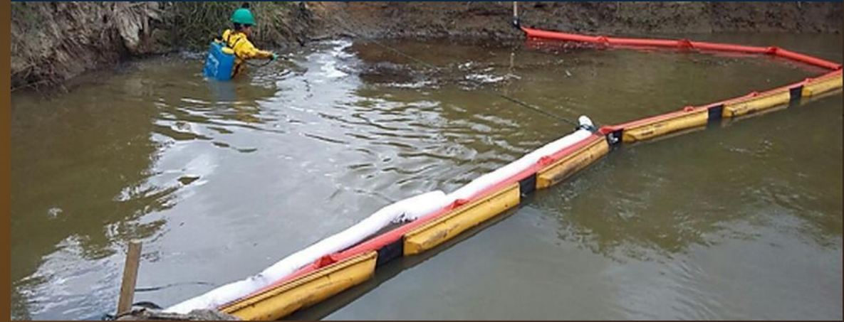
Labores de limpieza en el canal de riego
